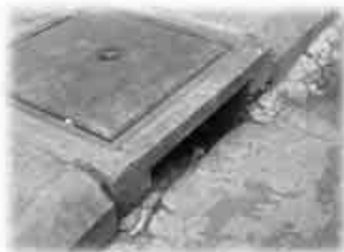
フランス植民地時代に造られた側溝。 街の至るところで目にする事ができる。
